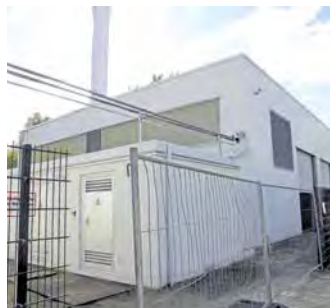
Das BHKW Berkenbrücker Chaussee hat einen Anbau für die neue 20-kV-Trafostation erhalten
